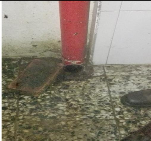
*Foto No. 3 Tubería de agua lluvia con adecuación para recepción de agua residual no doméstica generada en actividades de lavado de instalaciones, equipos, utensilios y áreas.*
